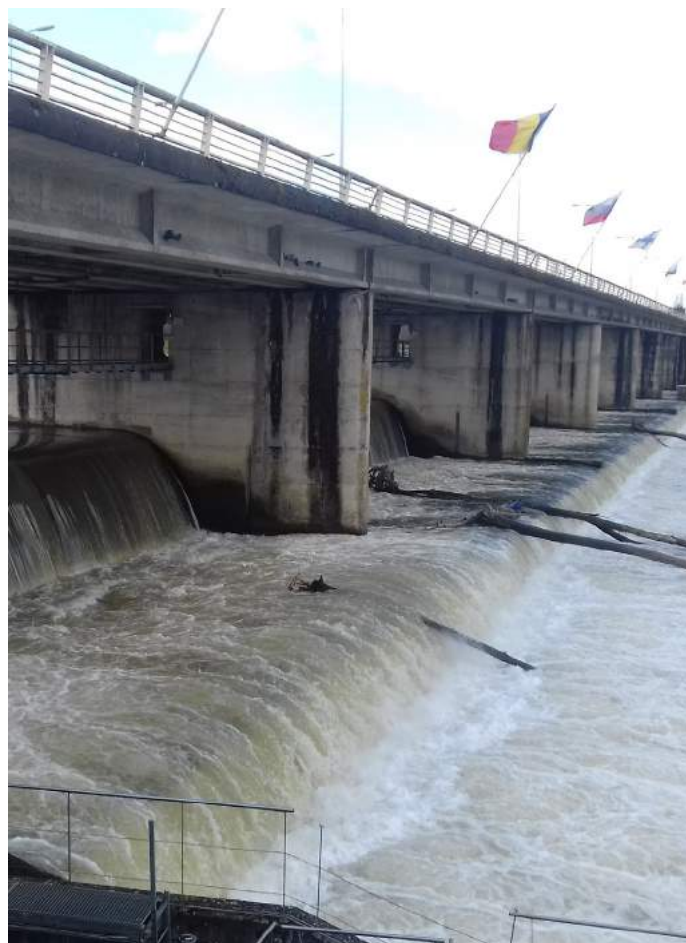
Un barrage infranchissable pour les espèces aquatiques - Vichy (Allier)
