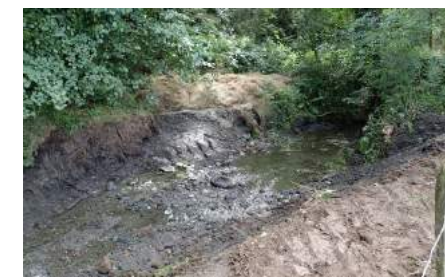
...après travaux ©FDAAPMA43
