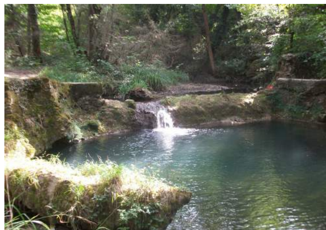
Seuil Foron avant travaux ©SMRD
