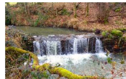
Seuil de Bourouge avant...
