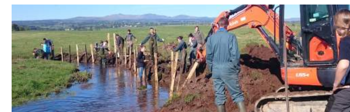
Restauration de berges avec des élèves de la section «génie végétal» © FDAAPPMA15
