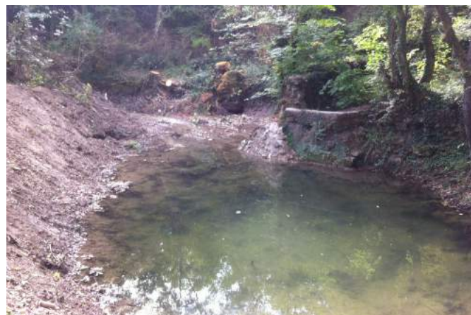
Seuil Foron après travaux © FDAAPMA26
