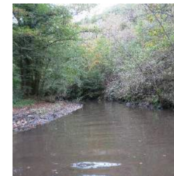
Avant suppression du seuil de la vallée en Barret sur le Garon ©FDAAPPM69
