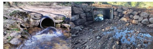
Avant travaux (photo 1) : buse initiale infranchissable à la moutaison. Après travaux (photo 2) : pont cadre remplaçant la buse après reprofilage du lit.
